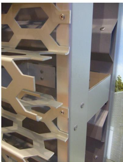
Exemple : rivetage d'un profilé en aluminium au bardage et rivetage de panneaux de tôles perforées à des supports de profilés alu
